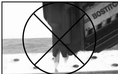
Colocación incorrecta del clavo
